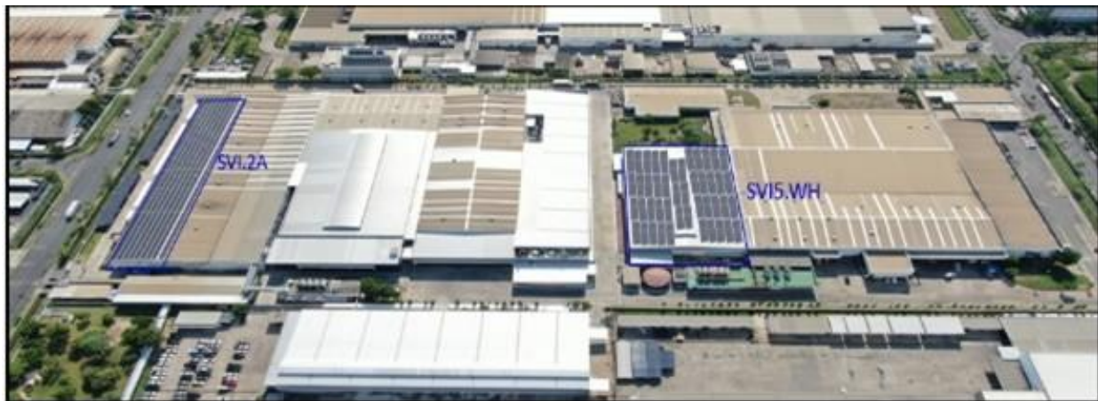
การติดตั้งแผงโซลาร์เซลล์เพื่อผลิตพลังงานไฟฟ้าจากพลังงานแสงอาทิตย์
